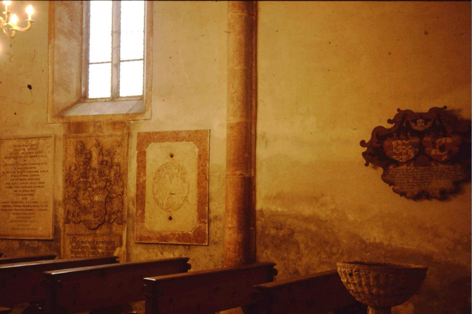
Mezzolombardo, chiesa di San Pietro, fianco sud
