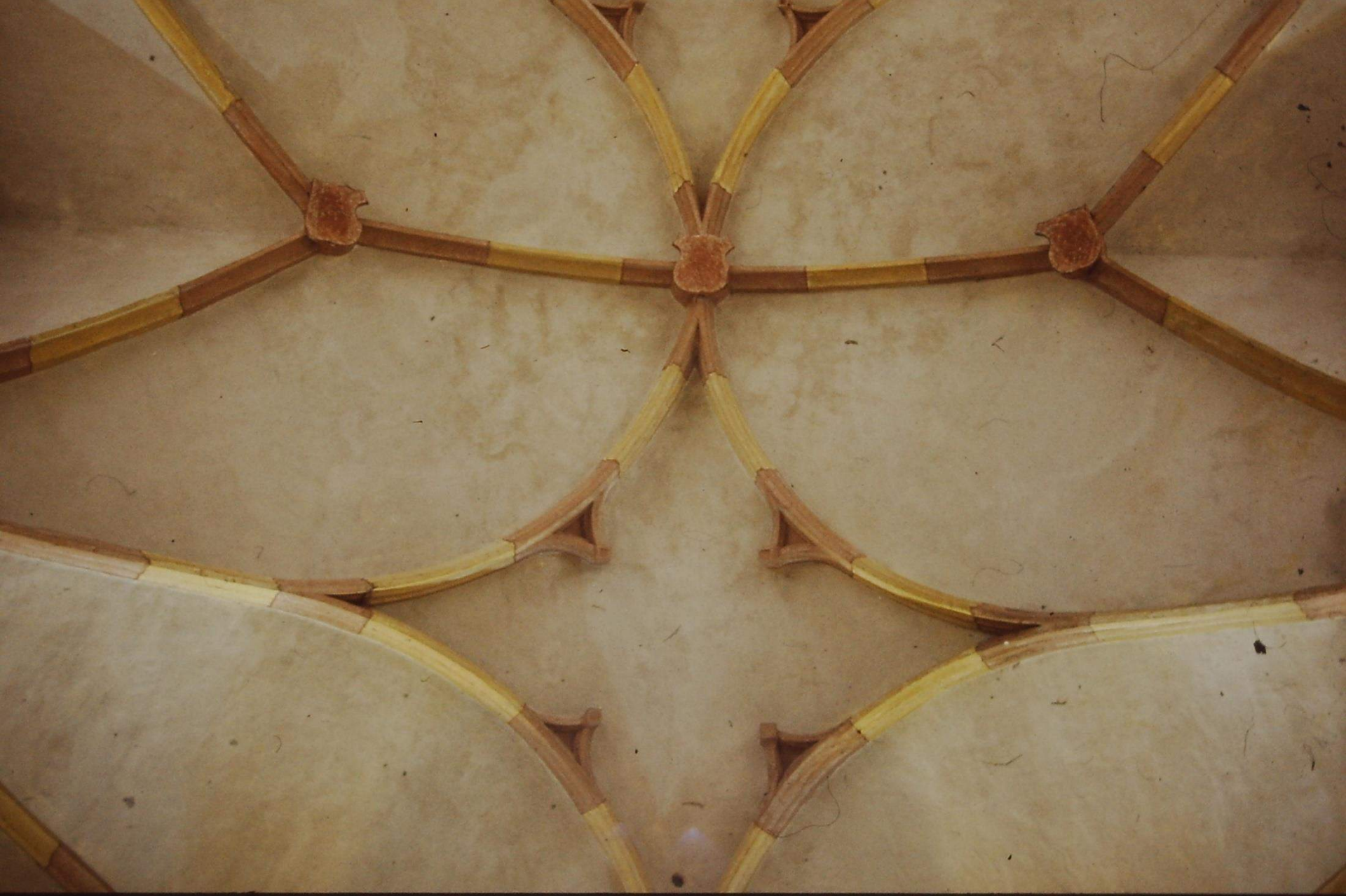
Mezzolombardo, chiesa di San Pietro, volta absidale
