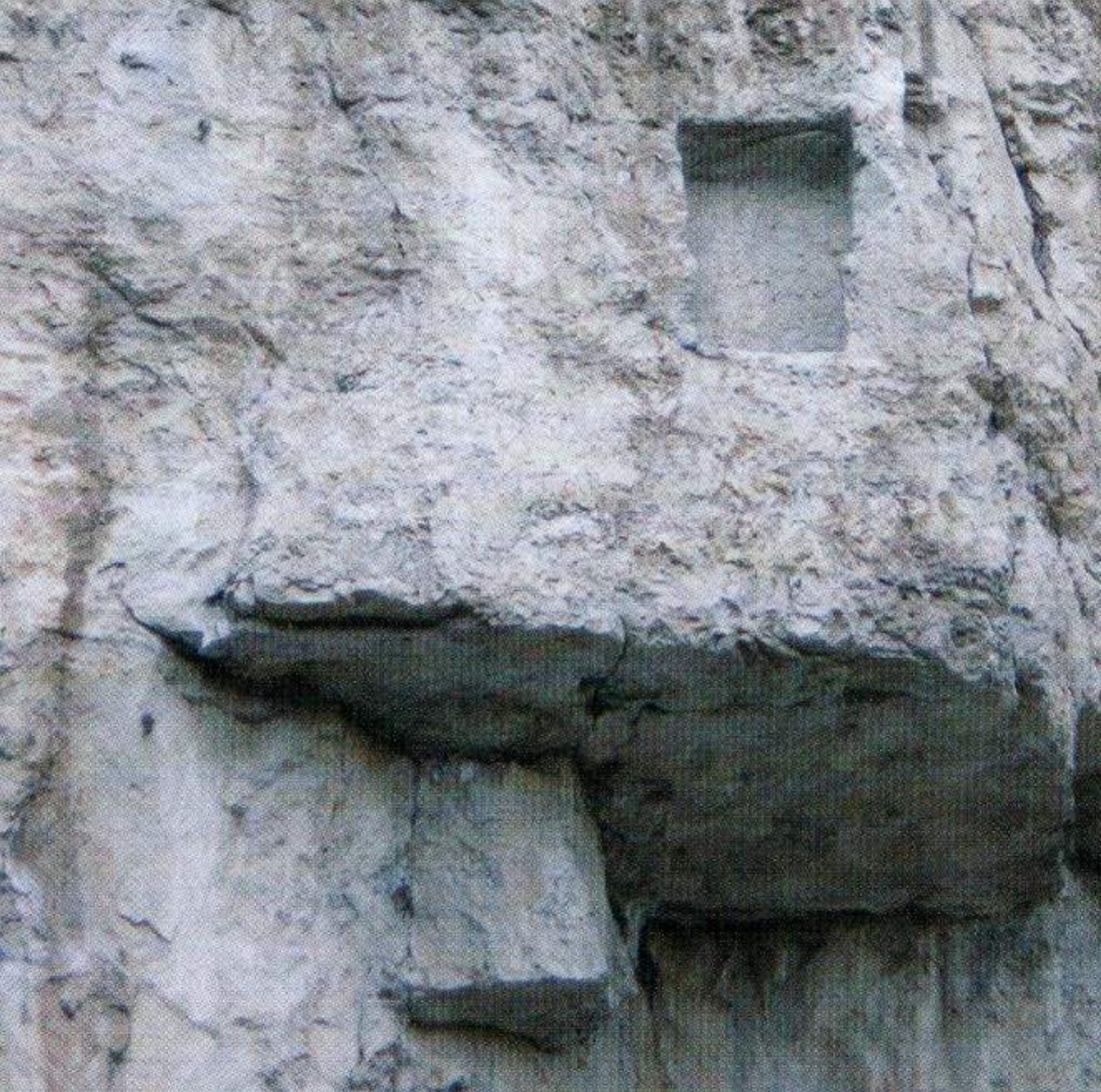
Pista di Finistrelle, particolare
